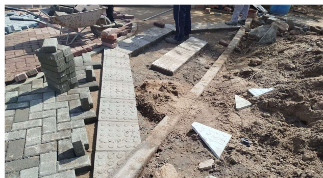
FOTO 2: EXECUÇÃO DE PISO INTERTRAVADO E GUIA DE MEIO FIO
