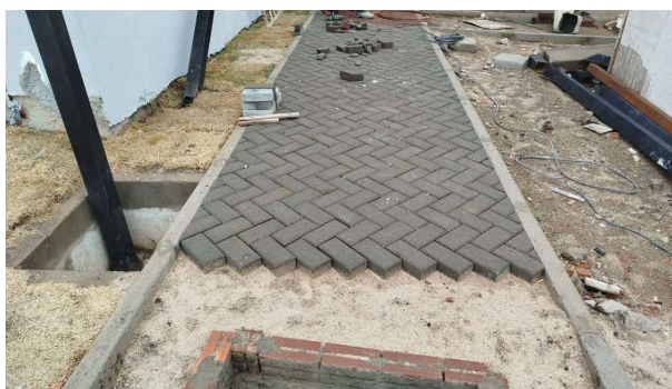
FOTO 1: EXECUÇÃO DE PISO INTERTRAVADO
