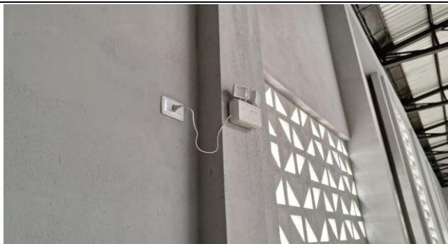
FOTO 9: | INSTALAÇÃO DE LUMINARIAS DE EMERGENCIA
