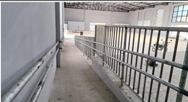
FOTO 20: INSTALAÇÃO DE CORRIMÃO
