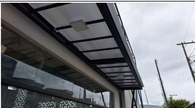
FOTO 13: | INSTALAÇÃO DE POLICARBONATO NA MARQUISE
