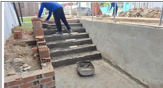
FOTO 27: |EXECUÇÃO DO PISO DA ESCADA DE ACESSO
