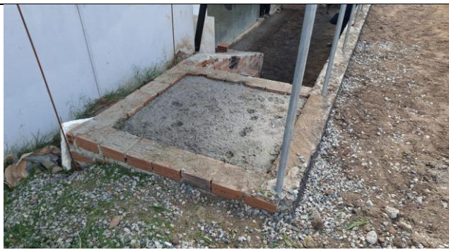
FOTO 28: |EXECUÇÃO DO PISO DA ESCADA DE ACESSO
