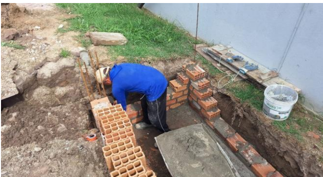
FOTO 22: ASSENTAMENTO DE ALVENARIA DA ESCADA DE ACESSO
