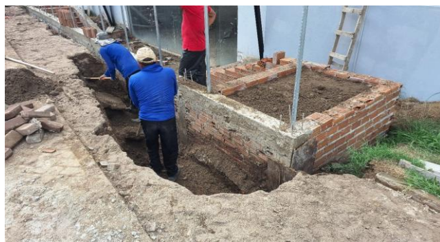
FOTO 25: PREENCHIMENTO DE VALAS COM ATERRO
