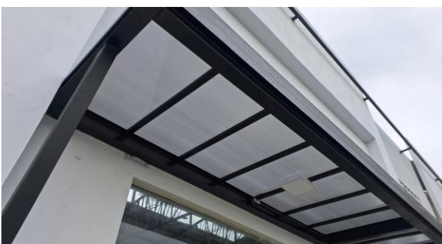
FOTO 15: | INSTALAÇÃO DE POLICARBONATO NA MARQUISE
