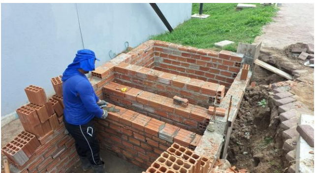
FOTO 21: ASSENTAMENTO DE ALVENARIA DA ESCADA DE ACESSO
