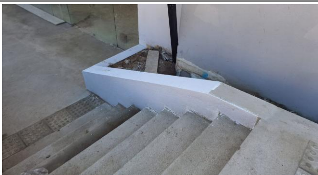
FOTO 32: |EXECUÇÃO DO PISO DA ESCADA DE ACESSO
