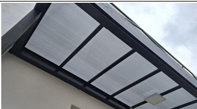
FOTO 14: | INSTALAÇÃO DE POLICARBONATO NA MARQUISE
