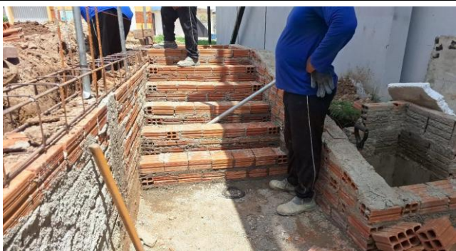
FOTO 23: ASSENTAMENTO DE ALVENARIA DA ESCADA DE ACESSO
