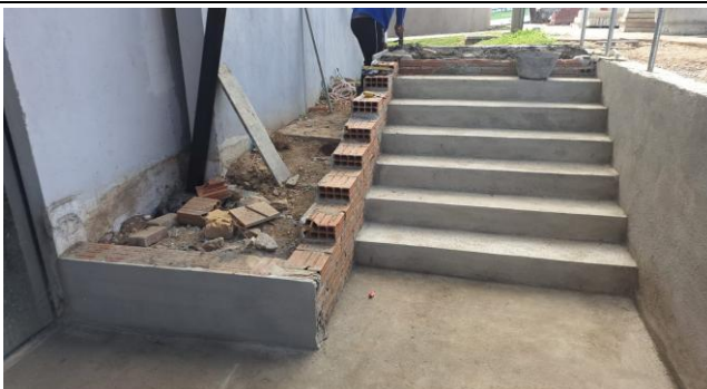
FOTO 30: |EXECUÇÃO DO PISO DA ESCADA DE ACESSO
