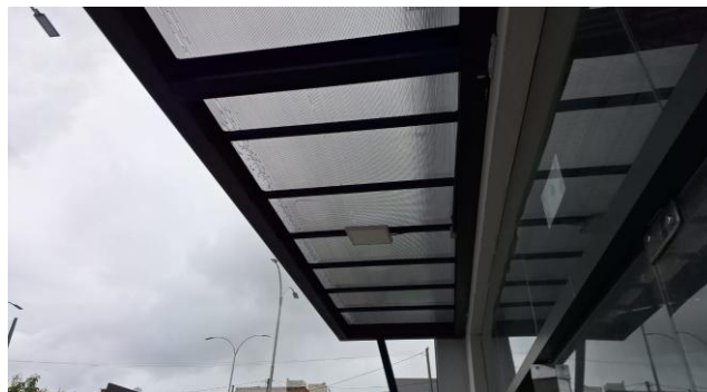
FOTO 16: | INSTALAÇÃO DE POLICARBONATO NA MARQUISE
