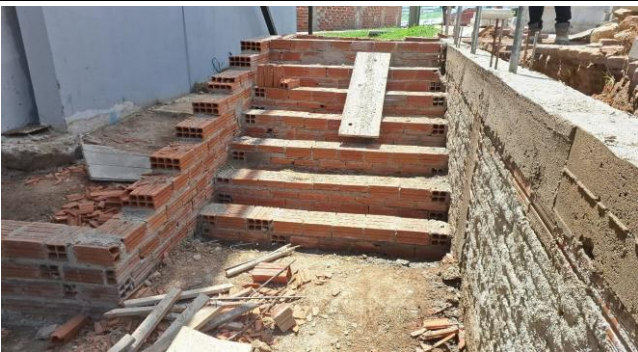
FOTO 24: ASSENTAMENTO DE ALVENARIA DA ESCADA DE ACESSO
