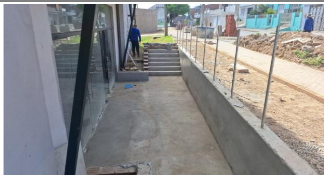
FOTO 29: |EXECUÇÃO DO PISO DA ESCADA DE ACESSO
