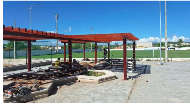
FOTO 16: CONFEÇÃO E INSTALAÇÃO DO PERGOLADO DE MADEIRA
