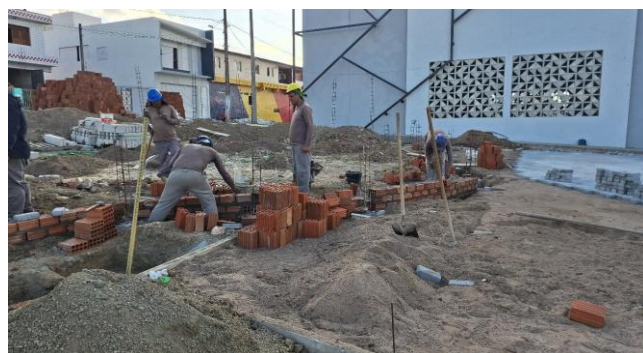
FOTO 20: MURETA DE CONTENÇÃO DE ATERRO E ESPALHAMENTO DE ATERRO
