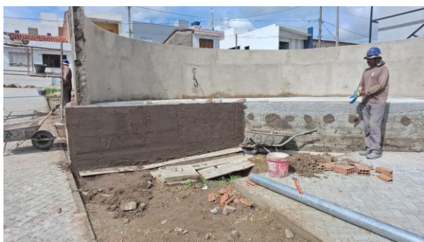
FOTO 21: APLICAÇÃO DE CHAPISCO NA MURETA DE CONTENÇÃO
