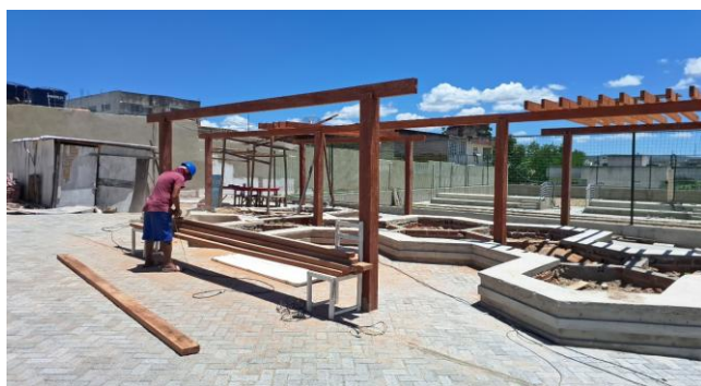
FOTO 9: CONFEÇÃO E INSTALAÇÃO DO PERGOLADO DE MADEIRA
