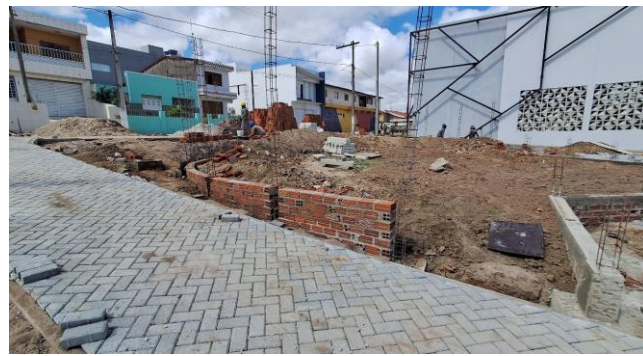
FOTO 18: MURETA DE CONTENÇÃO DE ATERRO E ESPALHAMENTO DE ATERRO
