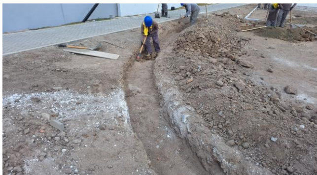
FOTO 17: ESCAVAÇÃO DE VALA PARA MURETA DE CONTENÇÃO DE ATERRO
