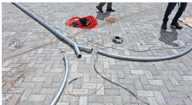
FOTO 3: INSTALAÇÃO DOS BRAÇOS DOS POSTES
