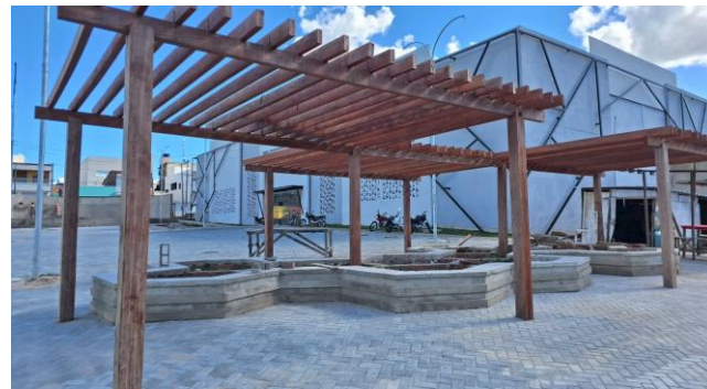
FOTO 12: CONFEÇÃO E INSTALAÇÃO DO PERGOLADO DE MADEIRA
