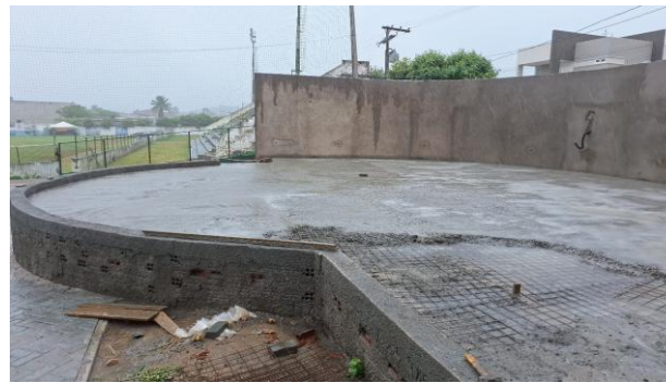
FOTO 26: CONCRETAGEM DO PISO DO PALCO
