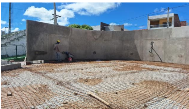
FOTO 25: CONCRETAGEM DO PISO DO PALCO
