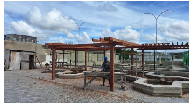
FOTO 10: CONFEÇÃO E INSTALAÇÃO DO PERGOLADO DE MADEIRA
