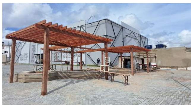
FOTO 13: CONFEÇÃO E INSTALAÇÃO DO PERGOLADO DE MADEIRA
