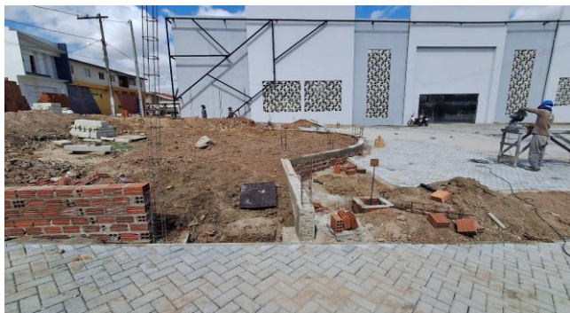
FOTO 19: MURETA DE CONTENÇÃO DE ATERRO E ESPALHAMENTO DE ATERRO
